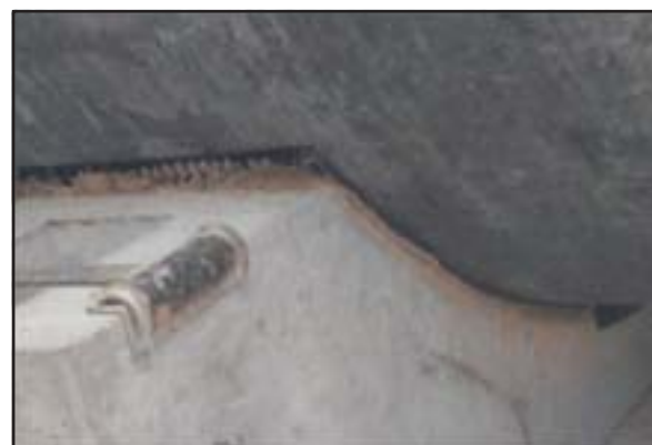
Slika 2: Postavljanje betonskih cijevi na profilirane LUCOBIT® bandaže
